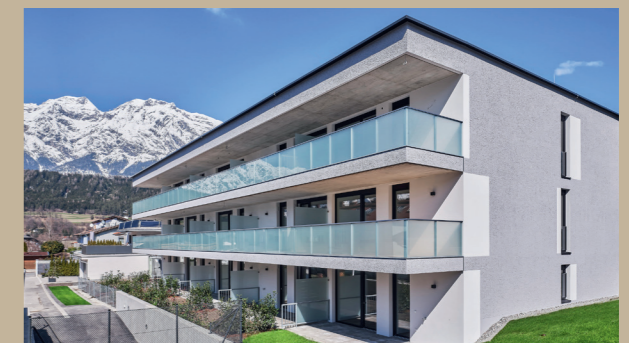
Wohnanlage – LIVEinn – Volders
