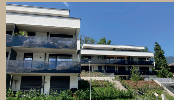
Wohnanlage – Gaisberg Terrassen – Vomp
